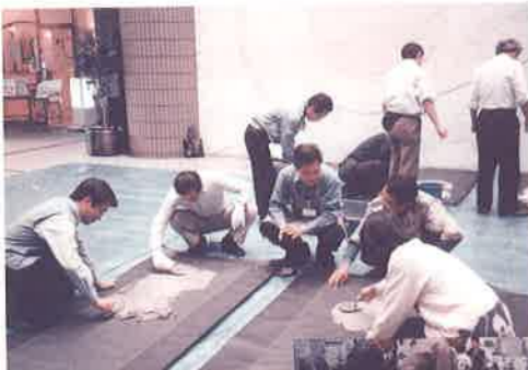
モルタル壁の補修法の実習風景 (ラスタホールにて)
